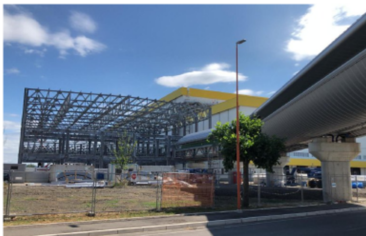
Il cantiere in corso d'opera all'Orogel
